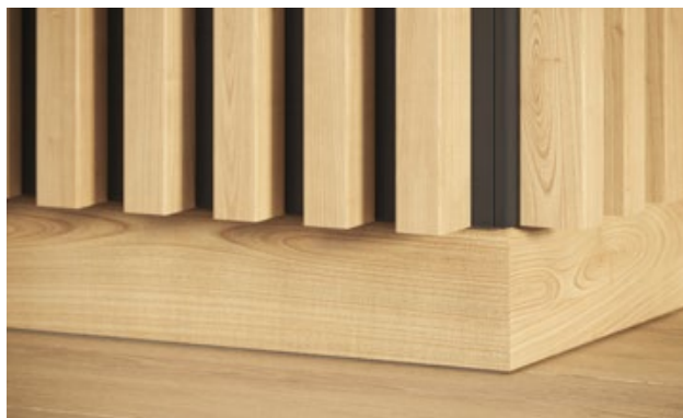
ukázka ukončení dekoračního panelu nad podlahovou lištou
